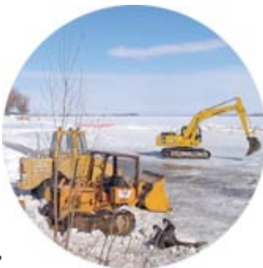
Travaux sur glace
